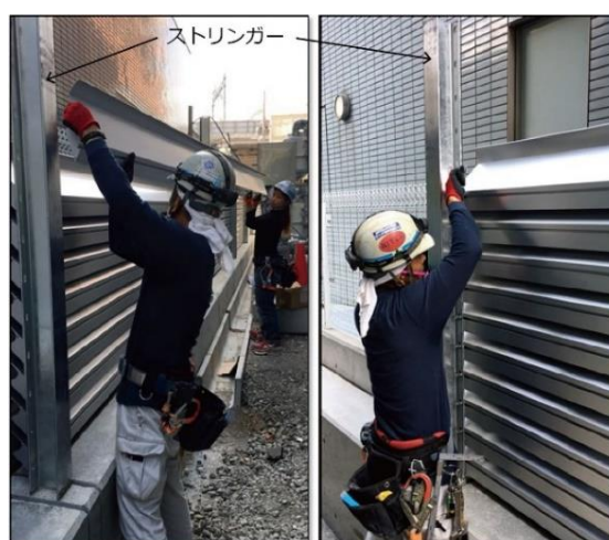
図表 4 取付作業状況
