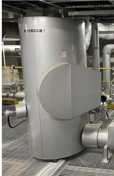
図表 5 尿素分解反応器外観 (約 2m×2m)
