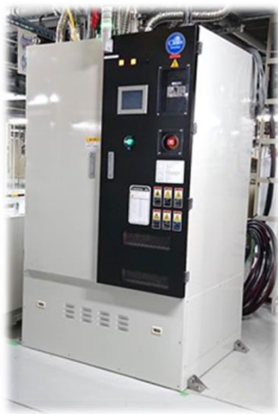
図表 1 国内最新半導体工場稼働中の装置
