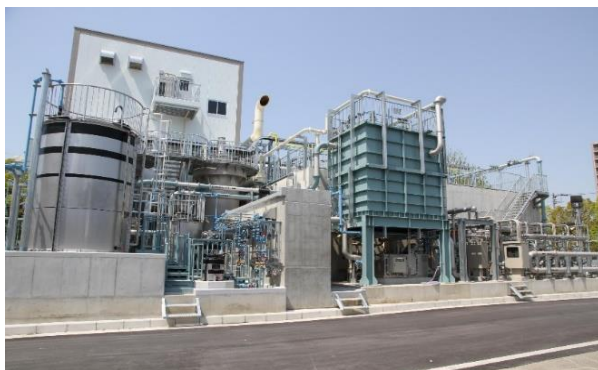
図表5 施設全景写真
