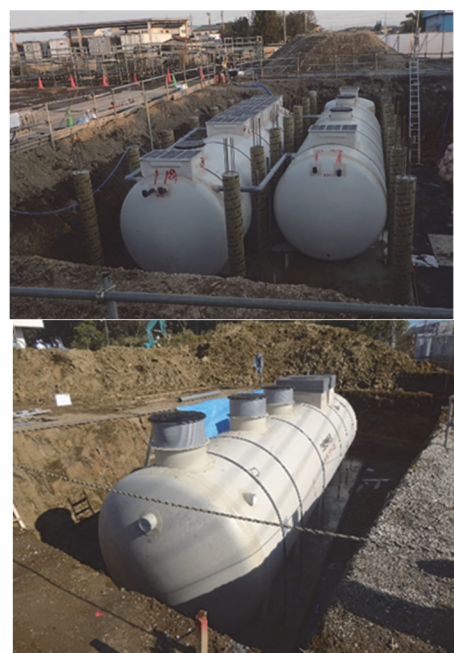
図4 大型浄化槽施工写真 (上：2本槽、下：1本槽の写真)
