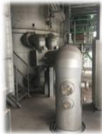
図表 8 局所攪拌空気吹込み技術設置状況
