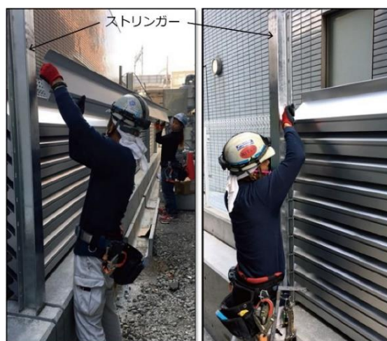
図表 4 取付作業状況
