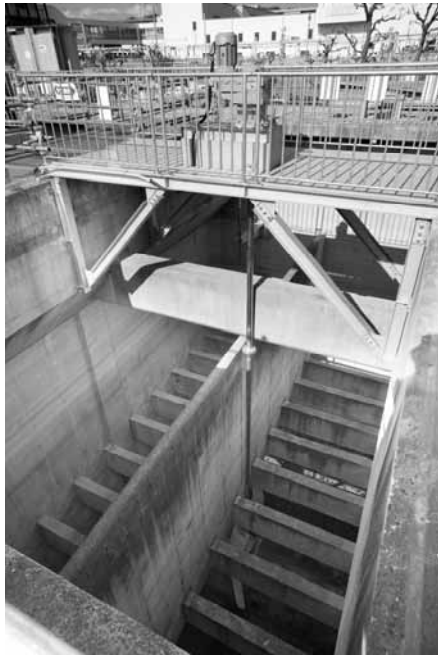
写真 3-1. 攪拌機設置状況(1)
