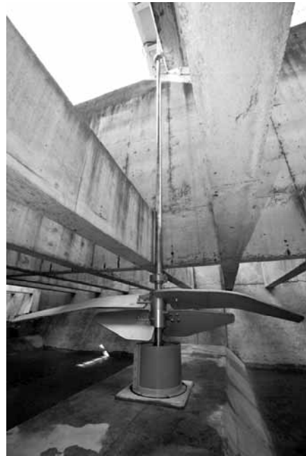
写真 3-2. 攪拌機設置状況(2)
